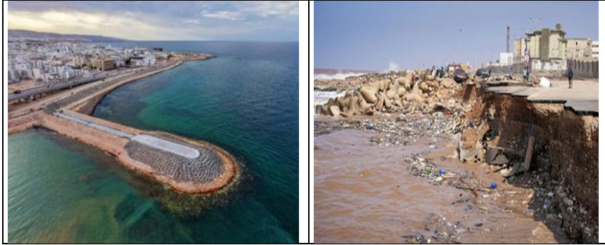
شكل 11: تآكل شط البحر وجرف الطرق نتيجة أعصار دانيال (اليمن)، وحماية الشط مابعد الاعصار (اليسار).
